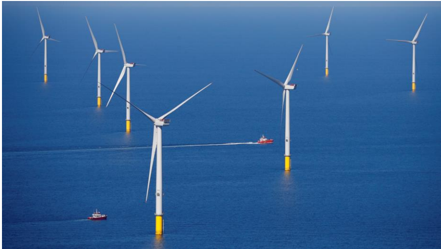
Vetrenjače koje energiju vetra pretvaraju u električnu energiju
